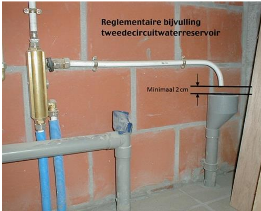
Figuur 4: AA-beveiliging bijvulinstallatie
