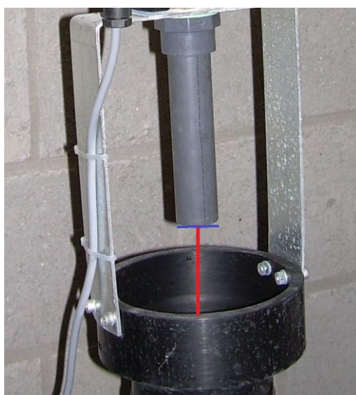
Figuur 6: bijvulstelsysteem zwembad: vrije uitloop
