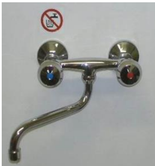
Figuur 5: wanverbinding mengkraan
